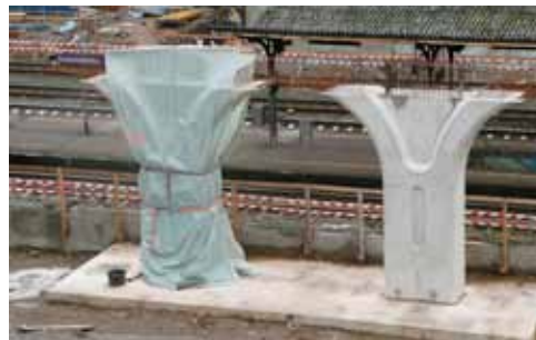
Schalung der Stützenkonstruktion
