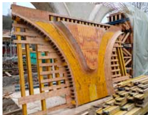
Stützenkonstruktion Brückenbauwerk
